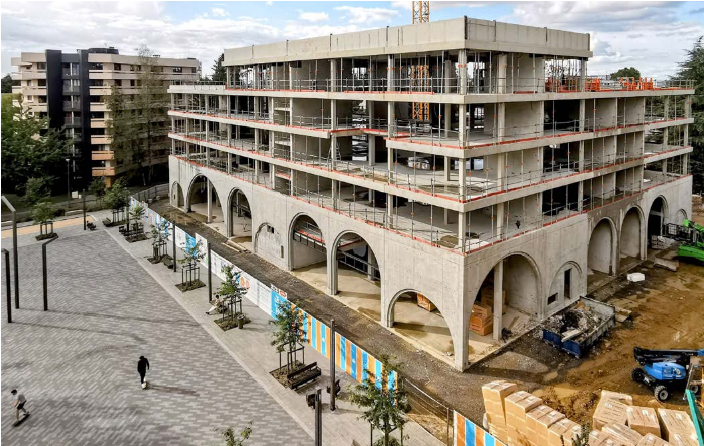
CoBe-WEEK_place-laherrere_vue hauteur chantier
