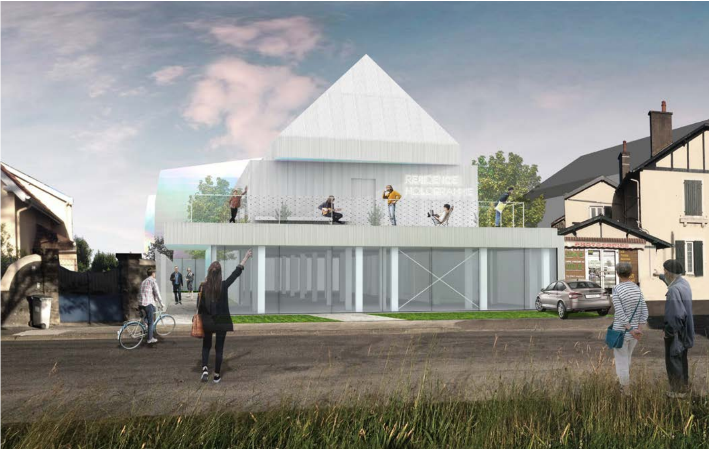
accès piéton, façade principal
